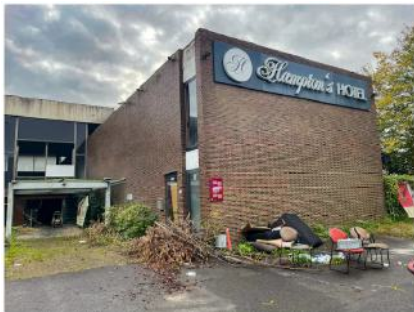
L'incendie à l'ancien hôtel Hampton's à Wépion s'est déclaré lundi 14 octobre en soirée. ©Vincent Lorent
